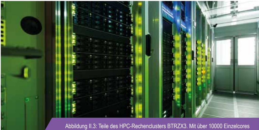
Abbildung II.3: Teile des HPC-Rechenclusters BTRZX3. Mit über 10000 Einzelcores wird BTRZX3 hauptsächlich für hochgradig parallelisierbare Berechnungen eingesetzt.
